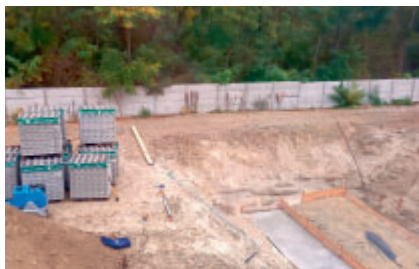
Obr. 4 – Budovanie základov novej haly
